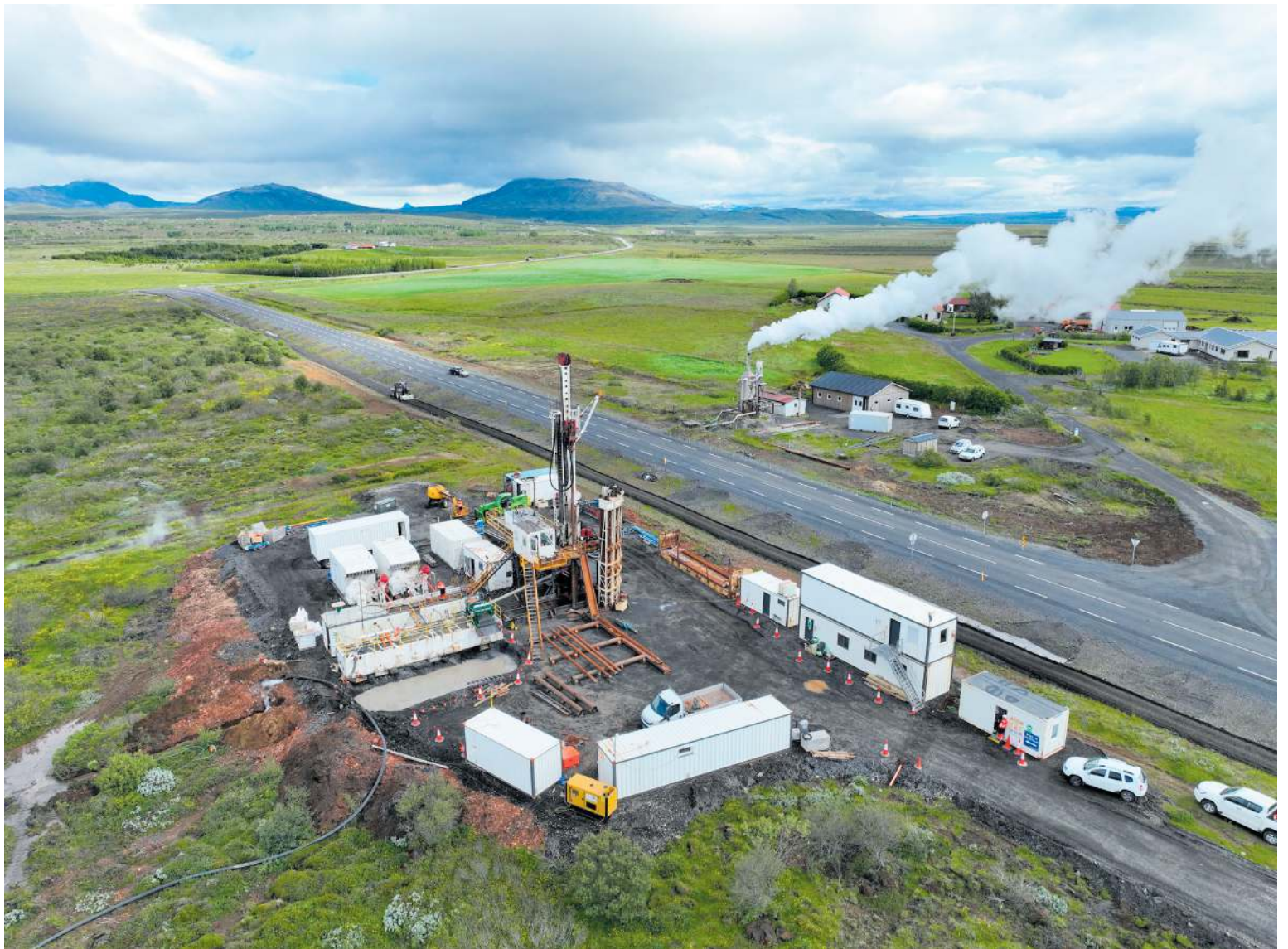
Borstaður Mökkurinn frá djúpu borholunni á Efri-Reykjum sést víða að. Nú er verið að bora aðra hliðina og er ætlunin að hefja raforkuframleiðslu.
